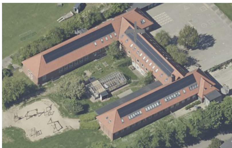
Figur 11: Solcelleanlæg på Eitang Skole
